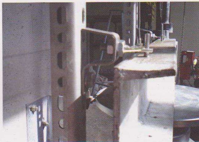
A trapézelem deformálódása
